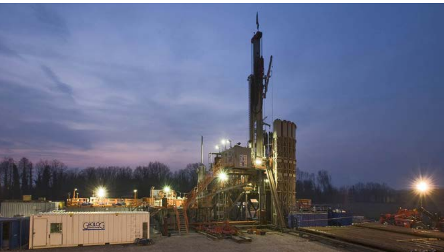
Sotto: Perforazioni a Bezzuca. Foto per gentile concessione di Po Valley.
