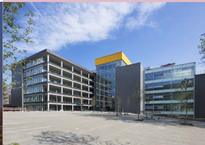
Sotto: Segreen Business Park. Foto per gentile concessione di of Lend Lease
